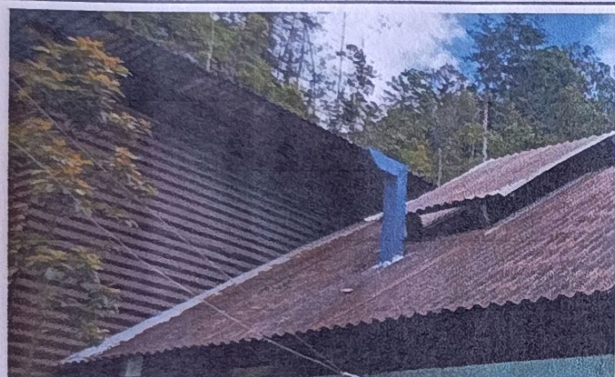
Foto 3: MODULO DE AULAS - Mejoramiento de techo
