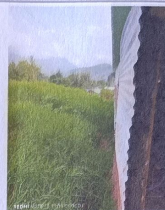
Foto 2: MODULO DE AULAS - mejoramiento de pared de lamina a pared de block
