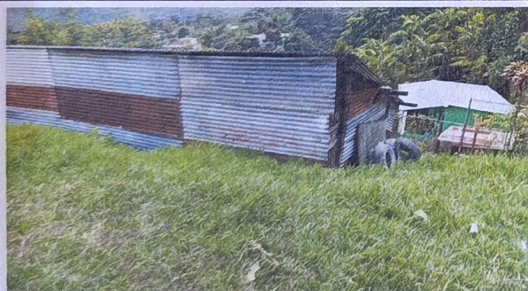
Foto 5: MODULO DE AULAS - Mejoramiento de pintura de aula
