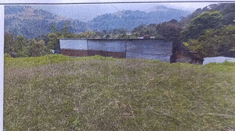
Foto 4: MODULO DE AULAS - El aula no cuenta con ventanas
